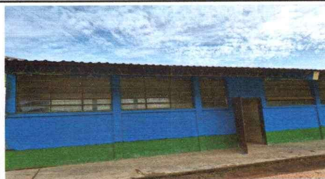
Foto 8: Colocación de canales.
