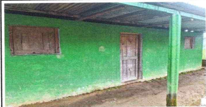
Foto 5: Sustitución de puertas y ventanas.
